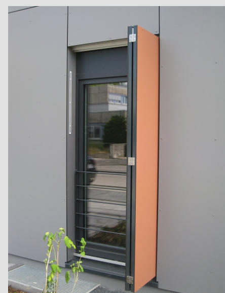
Verschattungselement und Lüftungsöffnung LUNOtherm
