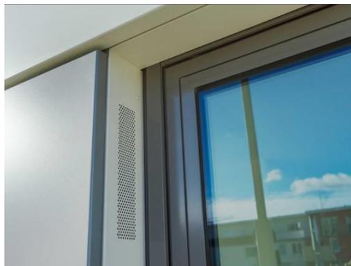
Das schmale Abschlusselement vereint Ästhetik und Schallschutz auf besondere Weise. Fertig installiert trägt es zu einer angenehmen Fassadenoptik bei.
