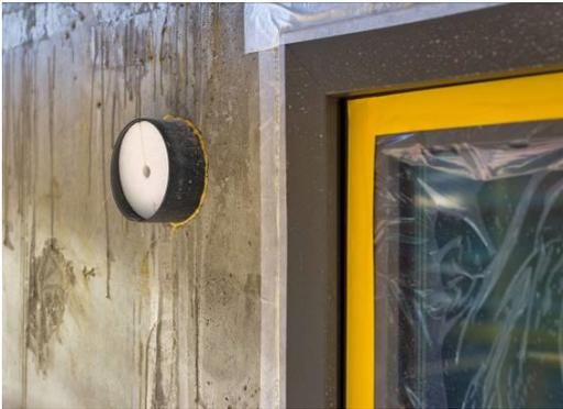
Die Fassadenelemente der LUNOtherm-Reihe werden mit den Unterputz-Klemmlüftern Silvento ec und den Außenwand-Einschüben ALD kombiniert.
