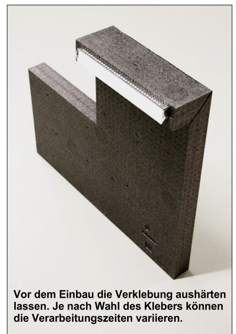
Die Bauteile sorgfältig zusammenkleben, so dass sich keine Luftundichtigkeiten bilden können.
