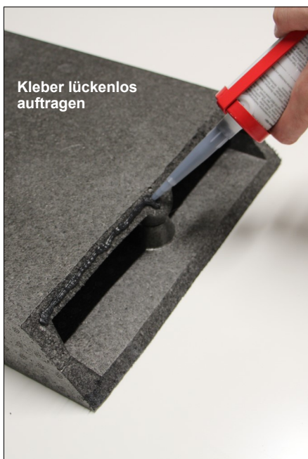
Die Bauteile sorgfältig zusammenkleben, so dass sich keine Luftundichtigkeiten bilden können.
