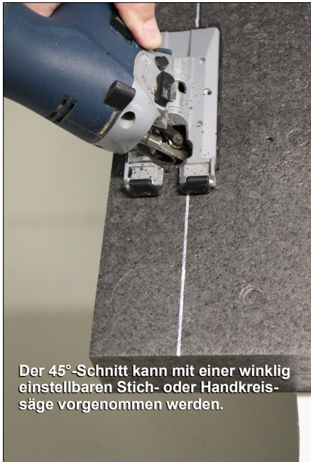
Ein präziser 45°-Schnitt ergibt einen perfekten 90°-Winkel für die Umlenkung des Lüftungsspalt nach vorn.
